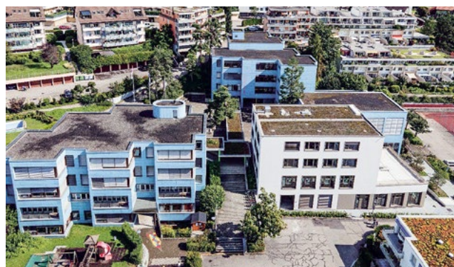
Die Fenster der Gebäudetrakte 1 und 2 (blau gestrichen) werden ersetzt.
